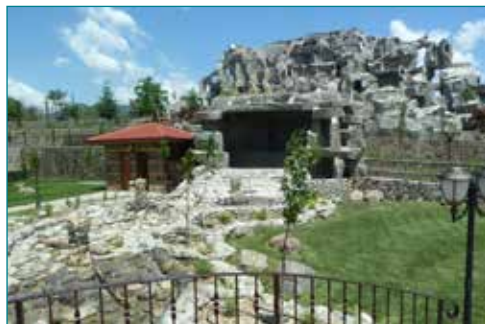
Konstrukce umělého vodopádu
