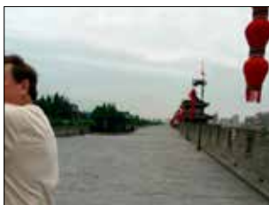
koruna pevnostní zdi
