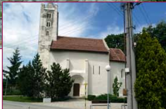
místní kostel z 13. století (Sv. Kříža)
